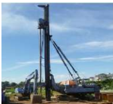
a. SCPile Machine
